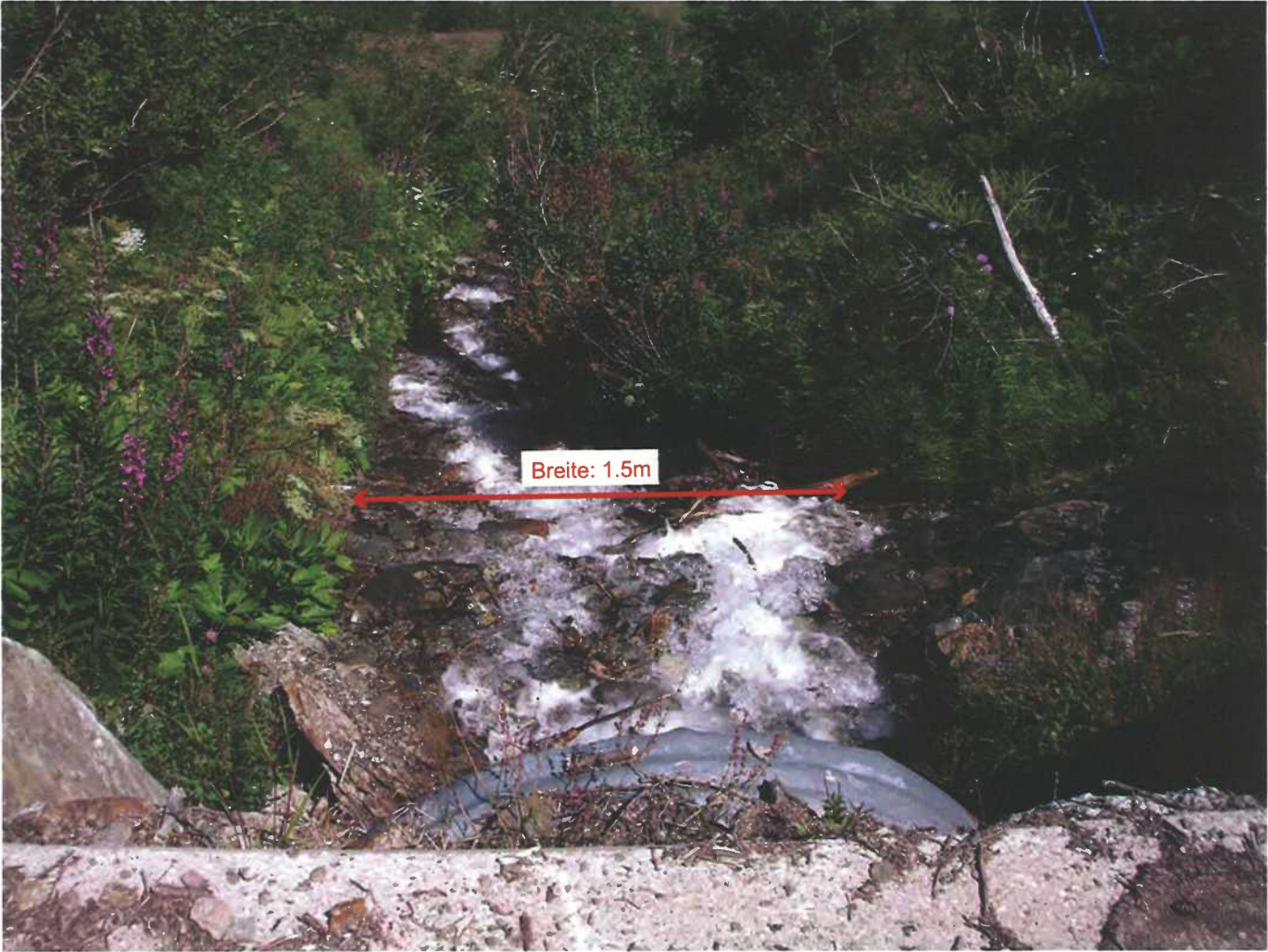
Foto bachabwärts: Abschnitt 1 (unterhalb Forststrasse), Wasserlauf offen. Gemessene Breite 1.5m QP BAE 1
