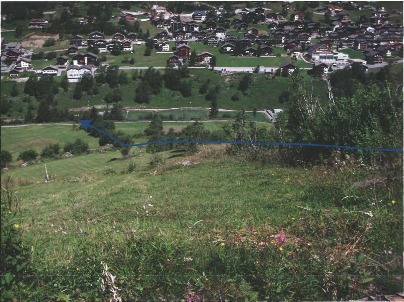
Übersichtsfoto: Abschnitt 2 (oberhalb Forststrasse), Wasserlauf offen. Gemessene Breite 1.5m
