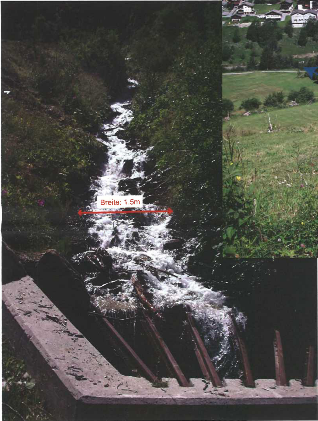
Foto bachaufwärts: Abschnitt 2 (oberhalb Forststrasse), Wasserlauf offen. Gemessene Breite 1.5m QP BAE 2
