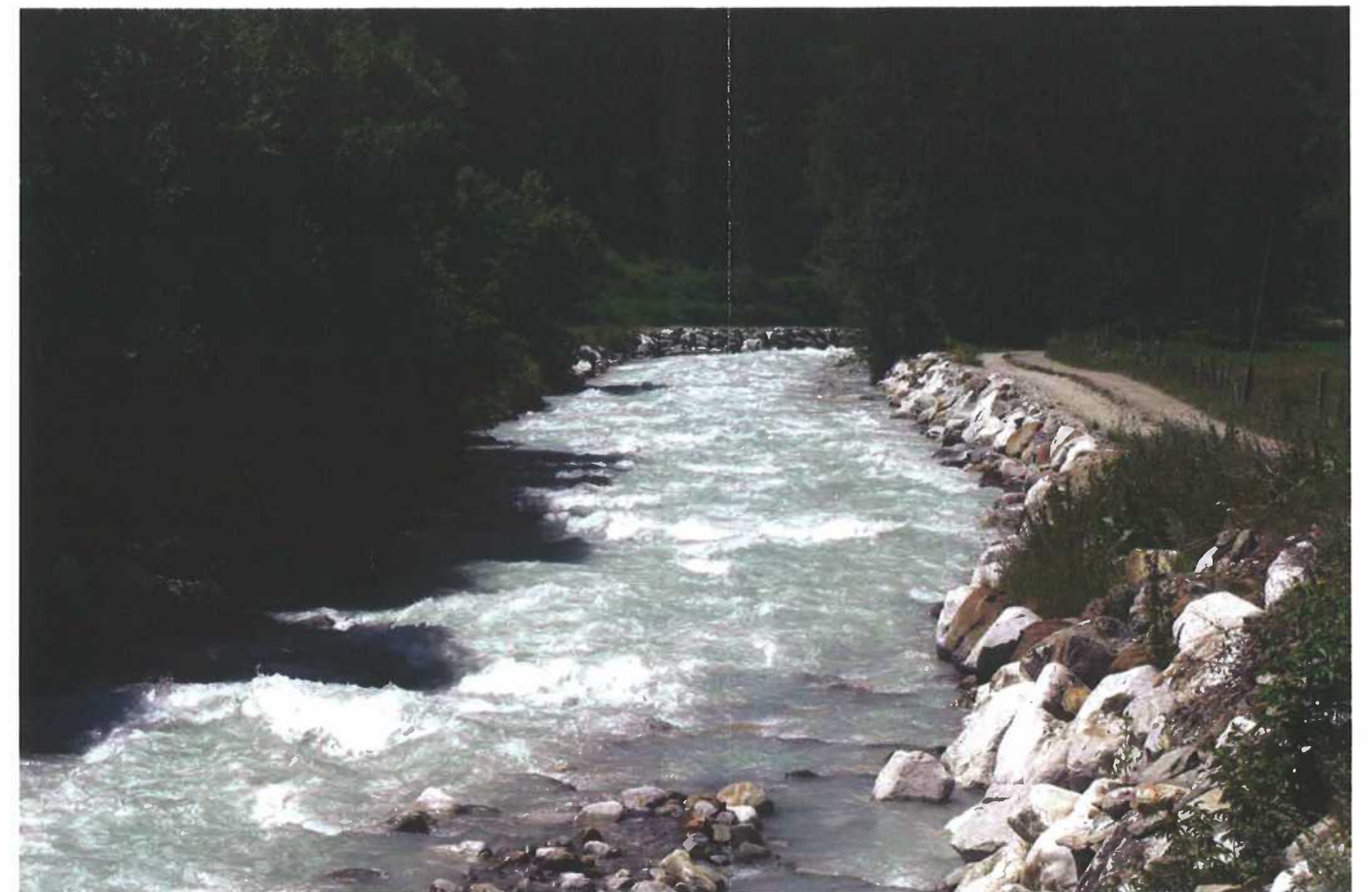
Foto bachabwärts: Lonza im Bereich Camping
