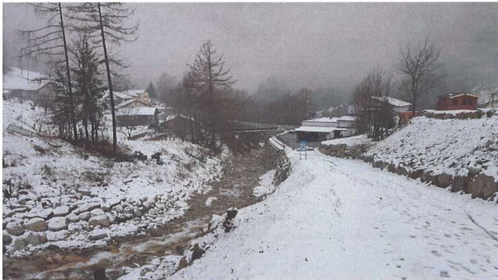
Figure 17 : DUR01, vue vers l'aval en direction du pont de la RC
