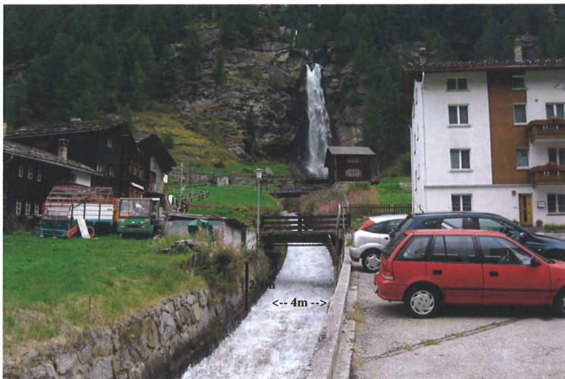
Foto bachaufwärts: Fellbach in Richtung QP FEL 2. Aktuelle Sohlenbreite: 4m
