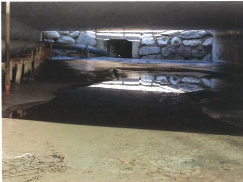
Foto bachabwärts unterhalb QP TAN 1
