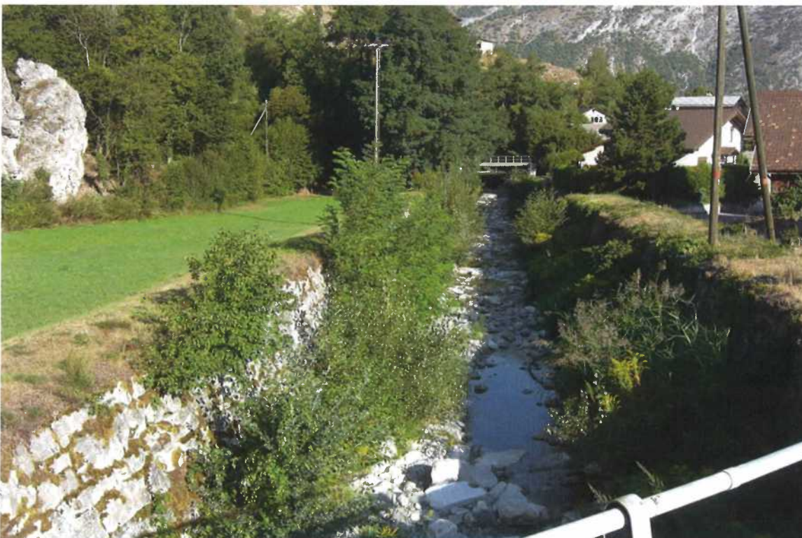
Foto bachabwärts in Richtung QP TUR 6. Rechtsseitig teils dicht überbautes Gebiet
