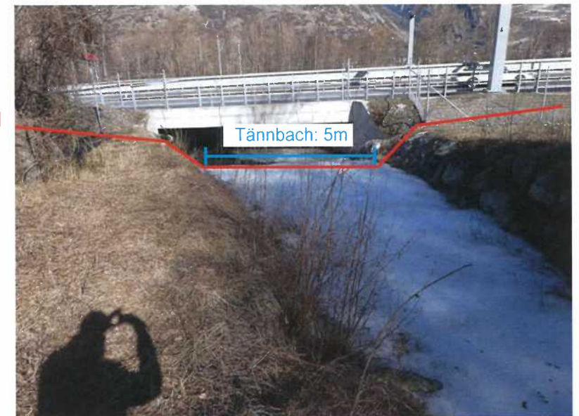
Foto bachabwärts in Richtung QP TAN 1
