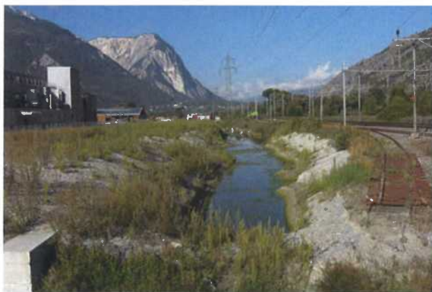
Foto kanalabwärts in Richtung QP PUT 1
