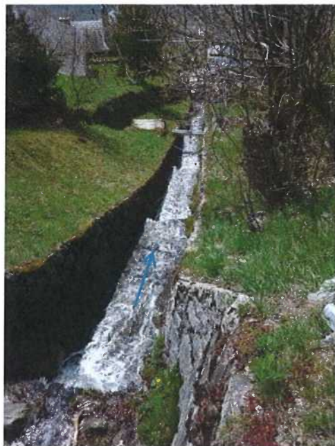
Photo 6-5 Canal en moellons avec seuils (photo de gauche vue vers l'aval) et sans seuil (photo de droite vue vers l'aval) – Secteur ALE-05
