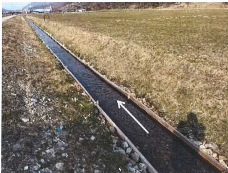
Photo 4-5 Tronçon CDC-01 vue vers l'aval
