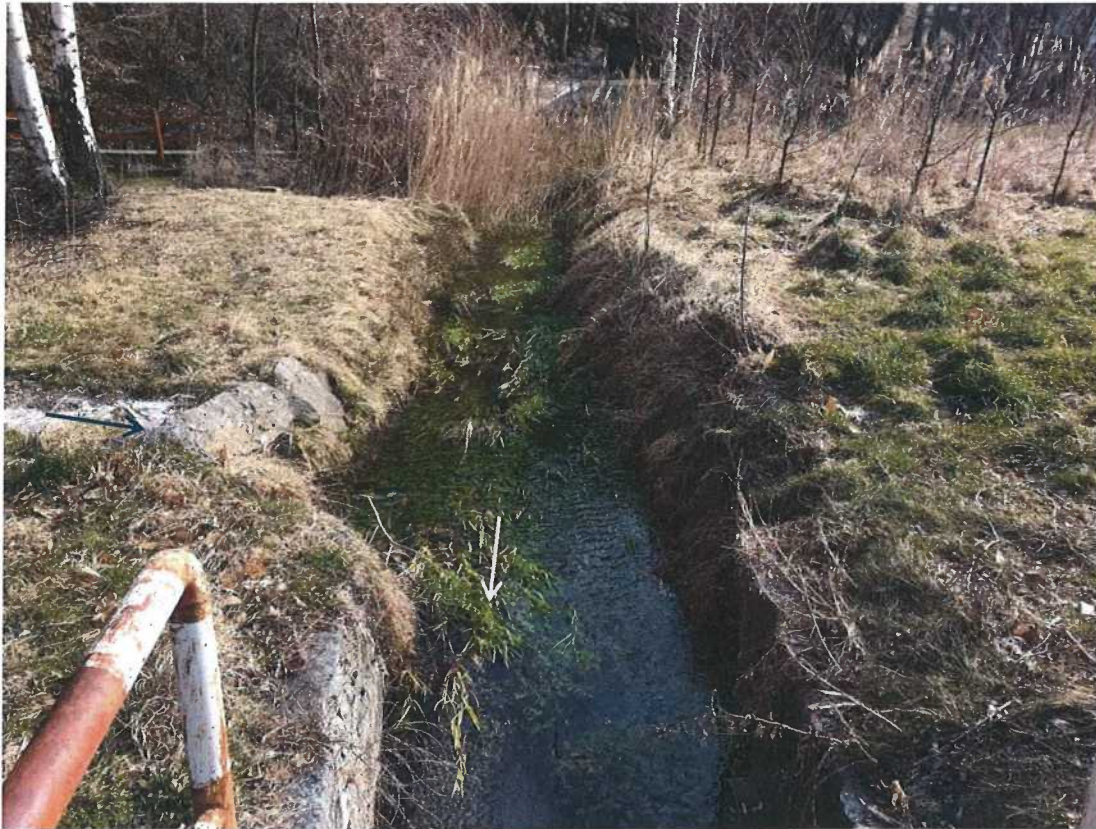
Photo 6-9 Début du secteur CDC-03, vue vers l'amont
