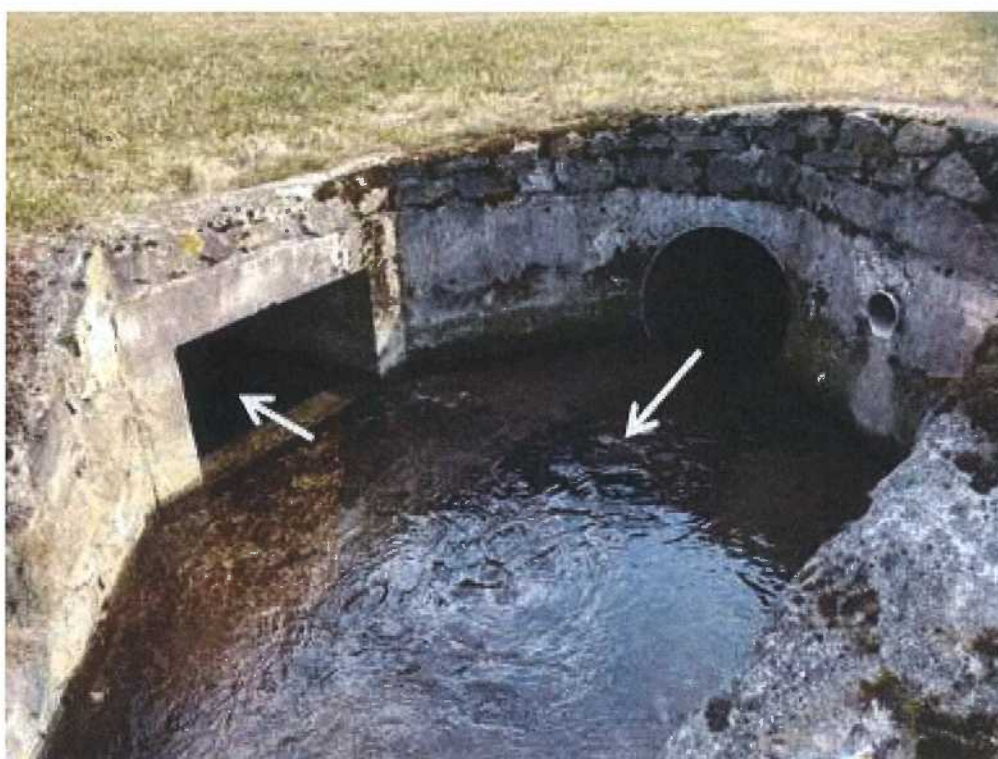
Photo 6-8 Passage sous conduite et transition entre CDC-01 et CDC-02
