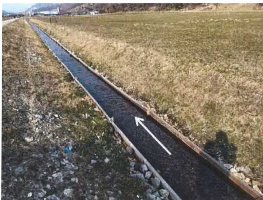
Photo 6-7 Tronçon CDC-01 vue vers l'aval
