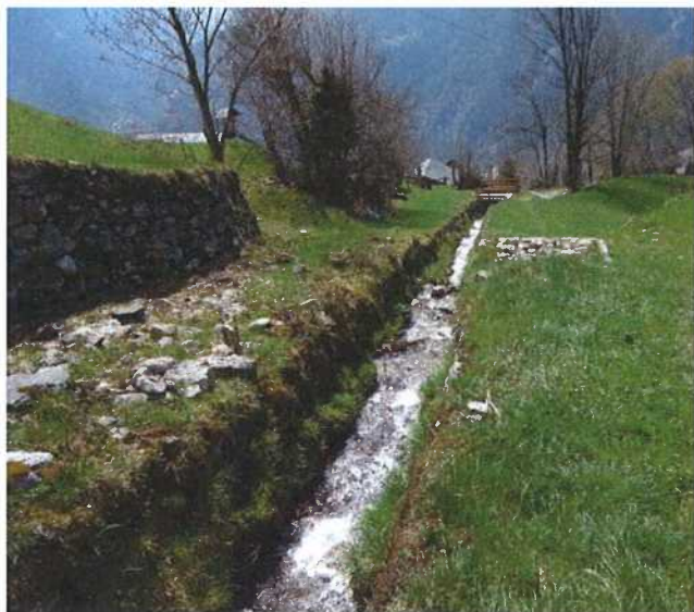
Photo 4-1 Canal en moellons avec seuils (photo de gauche vue vers l'aval) et sans seuil (photo de droite vue vers l'aval)
