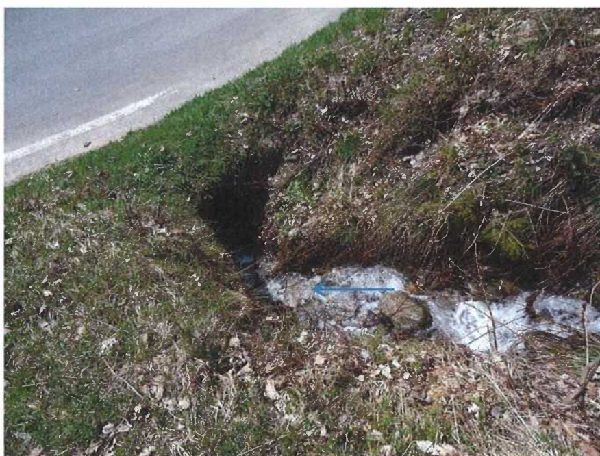
Photo 6-2 Tronçon aval du secteur ALE-08
