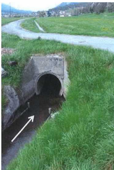
Photo 6-6 Passage sous conduite au niveau de la limite communale Dorénaz/Collonges. Secteur CDC-01
