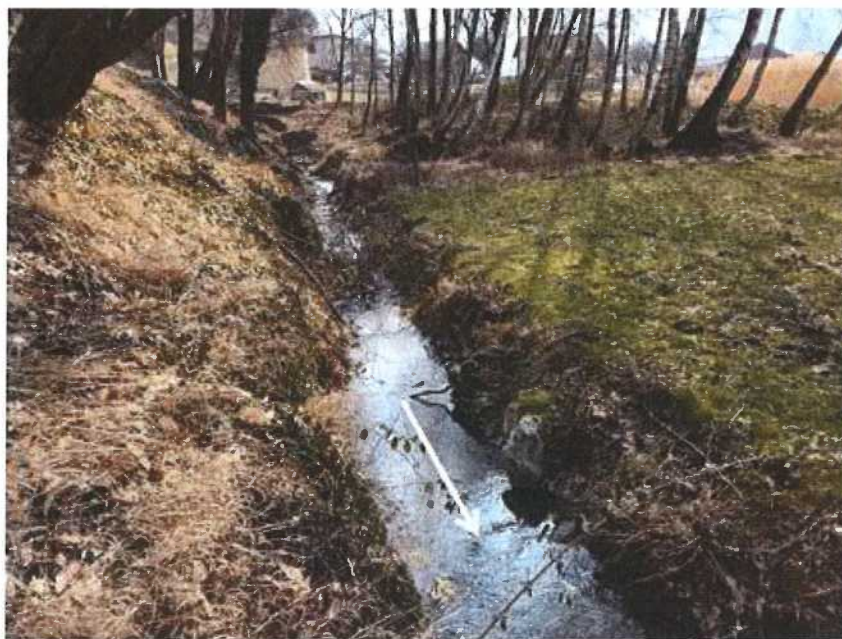
Photo 4-7 Tronçon CDC-03 vue vers l'amont (secteur aval alimenté par la source en pied de versant).
