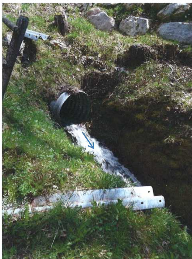
Photo 6-4 Amont du tronçon ALE-05
