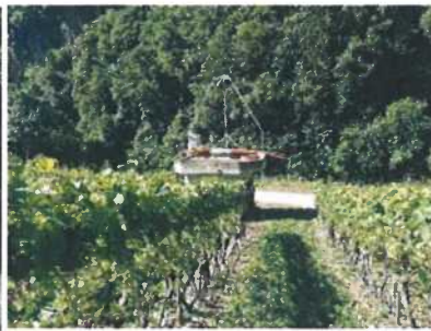
6140-MAI-01 (06.16) Ouvrage de sortie partie enterrée
