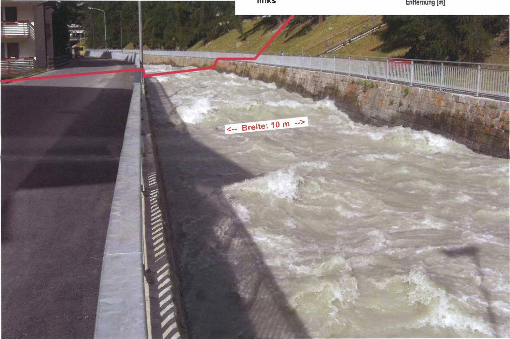
Foto bachabwärts: Vispa während Schwall
