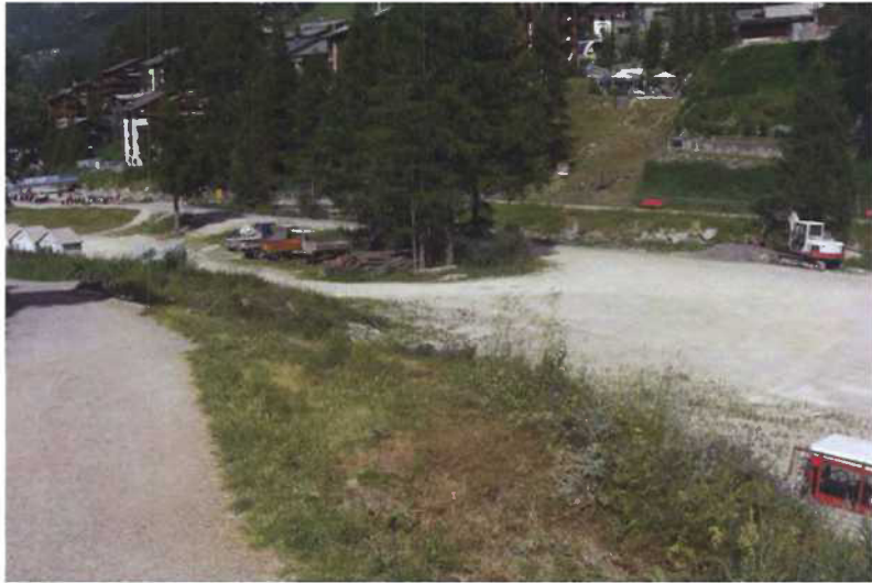
Übersichtsfoto Abschnitt 1: Ausser Hubelbach fließt ab Kreuzung Wanderweg eingedolt und mündet anschliessend in der Vispa.
