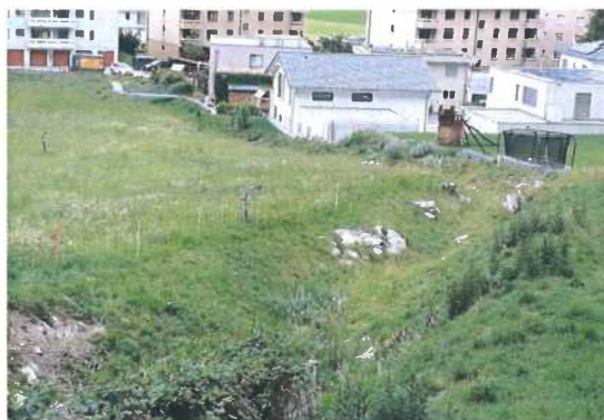
Abschnitt Low 2: Die Hochwasserentlastungsrinne liegt meistens trocken.
