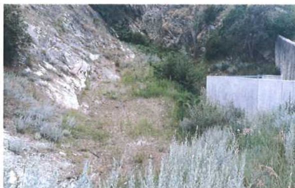
Abschnitt Low 1: Retentionsbecken mit Geschieberückhalt.
