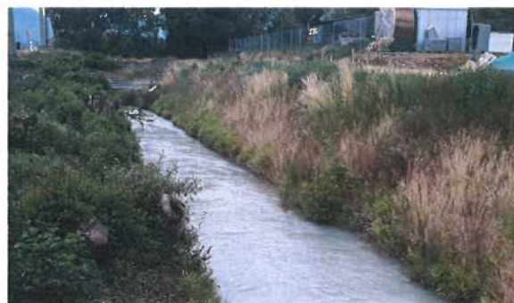
Abschnitt LAL2: Der Kanal weist gemäss Messungen vor Ort eine Breite von 2 m auf.
