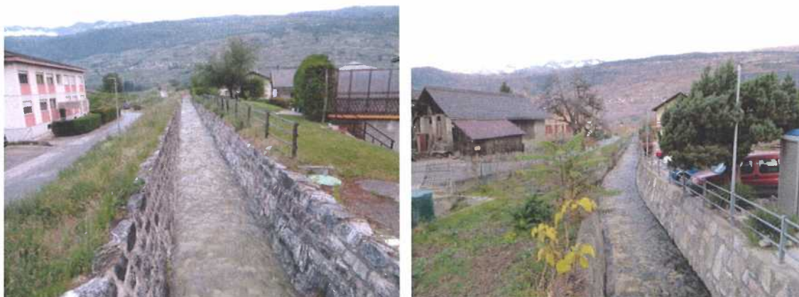
Figure 10 : La Rèche canalisée en aval de la Place Praniviers
