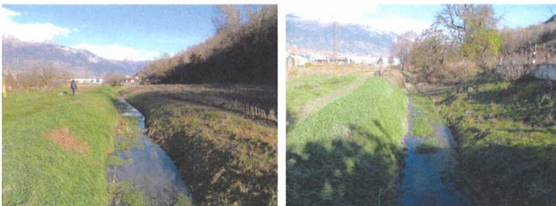
Figure 30 : Le canal des Zittes vue vers l'aval, hors zone à bâtir
