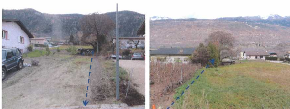
Figure 23 : Le torrent du Taillis sous tuyau, vue vers l'amont depuis le chemin de Chorechalaz et vue vers l'aval depuis la rue des Harroz
