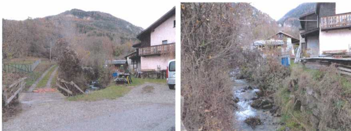
Figure 16 : La Rèche, en amont de la zone à bâtir, vue vers l'amont.
