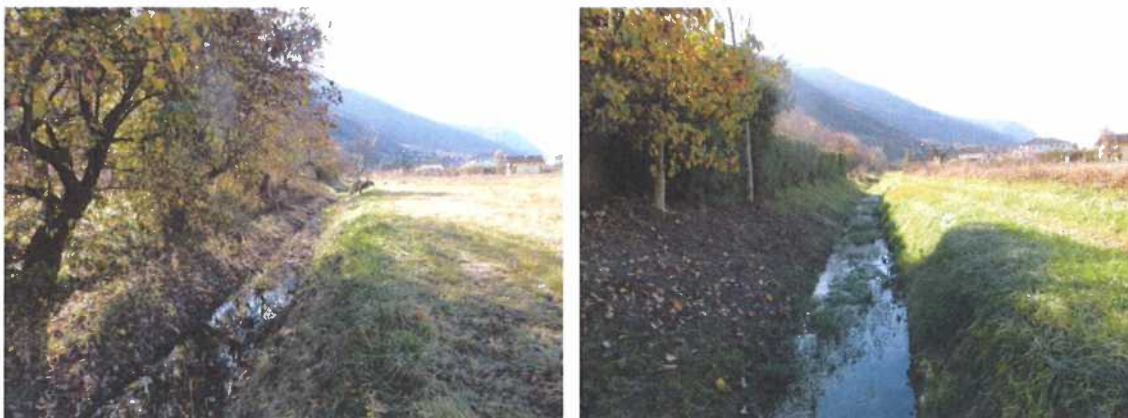
Figure 7 : Canal des Zittes à travers la zone agricole
