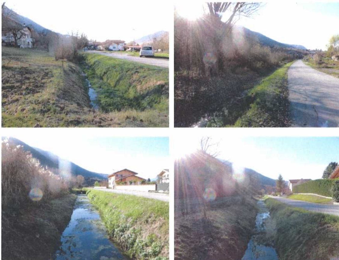
Figure 29 : Le canal des Zittes, vue vers l'aval, le long de la rue du Bord du Canal
