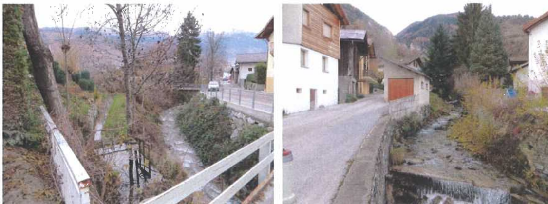
Figure 14 : La Rèche dans le centre village, depuis le pont de la rue des Moulins, vers l'aval et vue vers l'amont
