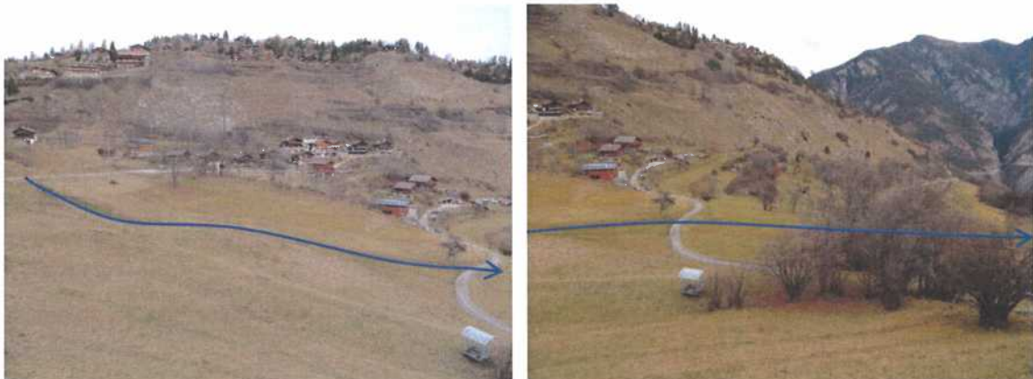
Figure 28 : Le torrent du Marais à travers les pâturages en aval de Vercorin
