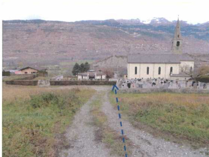
Figure 22 : Le torrent du Taillis sous tuyau en amont du Cimetière
