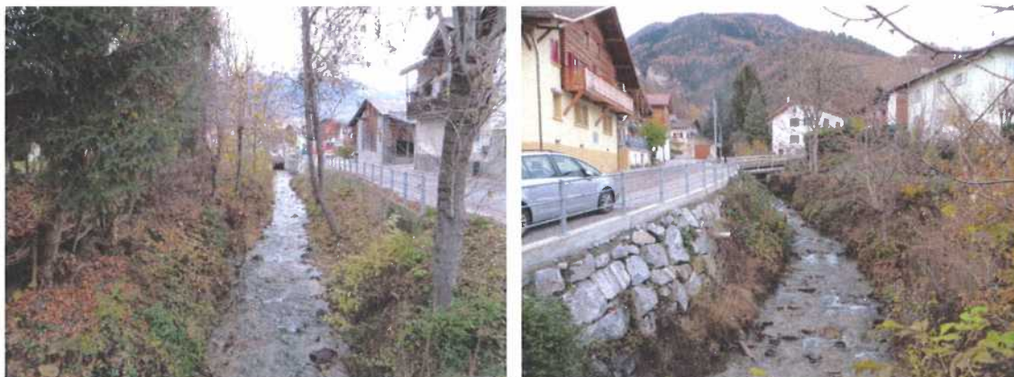
Figure 13 : La Rèche dans le centre village, depuis la passerelle, vue vers l'aval et vue vers l'amont
