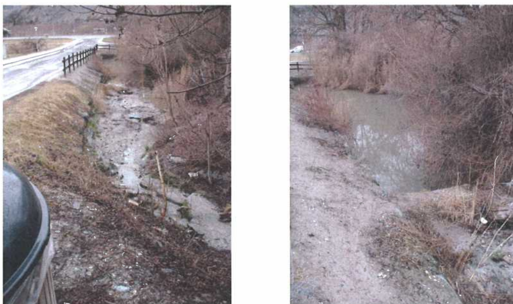
Figure 21 : Le torrent du Taillis, dessableur aval
