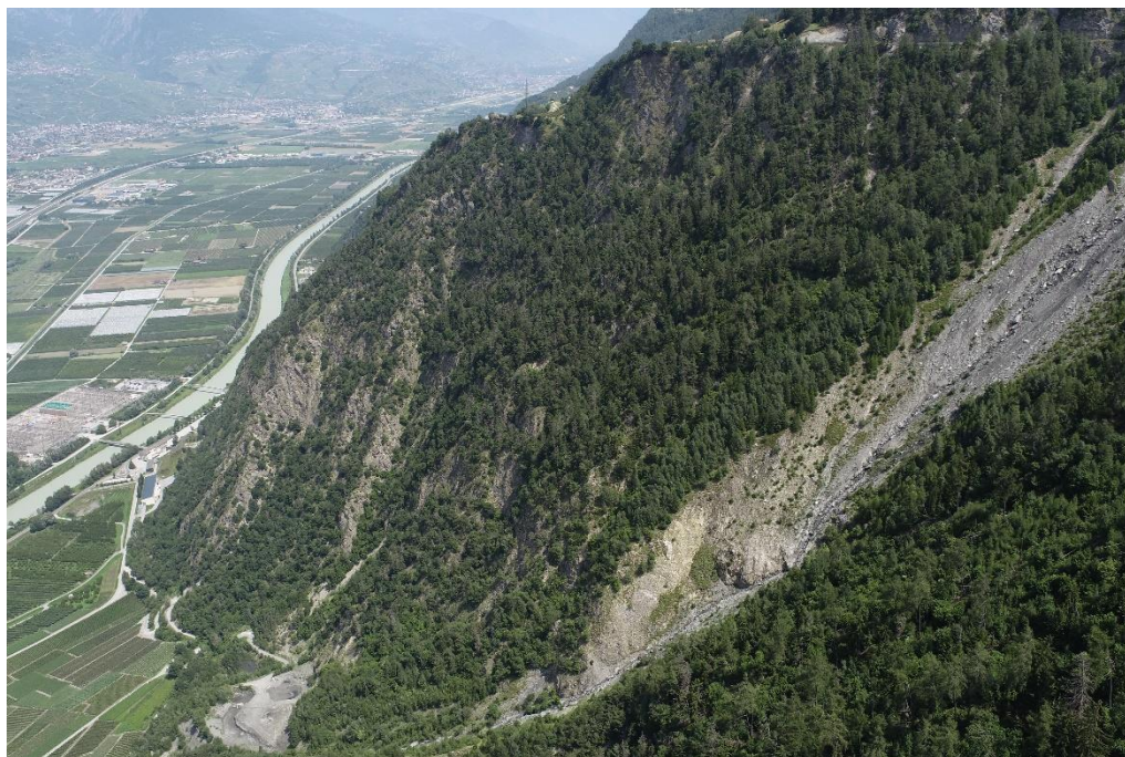
Figure 5 : Pentescarpées au nord du glissement des Crêteaux.
