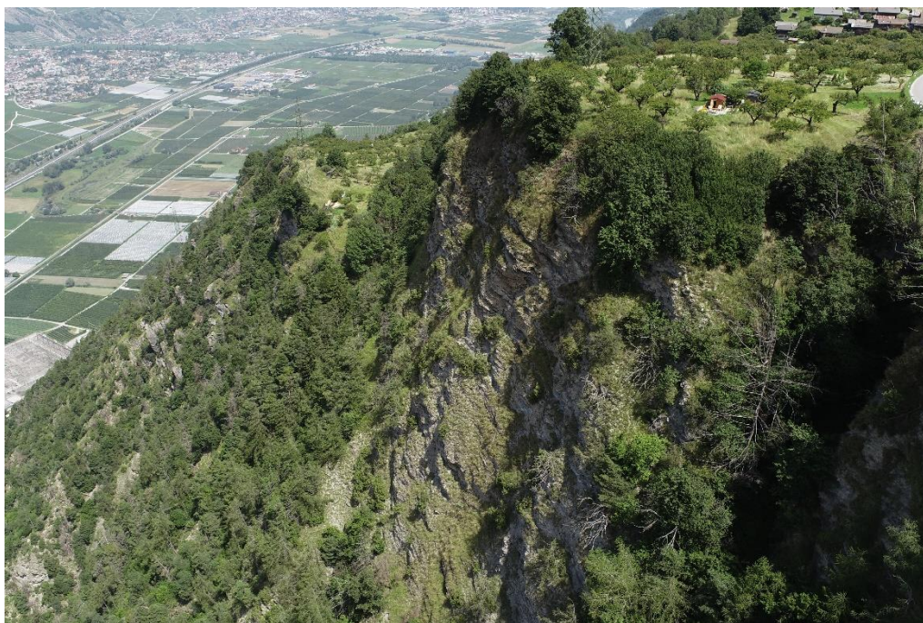
Figure 3 : Falaises de la forêt de l'Avantché, le hameau des Condémines est visible en haut à droite.
