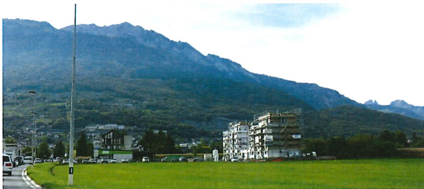
Figure 3 : vue sur les bâtiments en cours de construction sur la parcelle n°4857 (« Vers le Nant de Choëx – partie Sud »), depuis l'Avenue du Simplon
