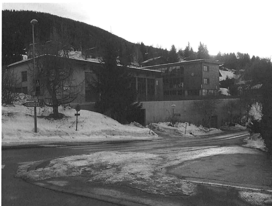
Photo n° 7 : Vue de l'école et de la RC 626 avec l'implantation projetée de la station d'arrivée à plain-pied (flèche rouge, variantes 3A et 3B).
