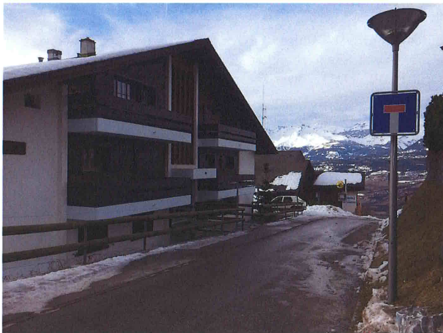
Photo n° 10 : Vue de la ruelle menant à la gare d'arrivée actuelle en contre-bas. La variante 1A nécessite le survol des deux bâtiments situés en aval (parcelles n° 2446 et n° 2398) alors que les variantes 2A et 2B nécessitent le survol de cette route et de l'habitation sise sur le bord amont (cf. photo n° 11).
