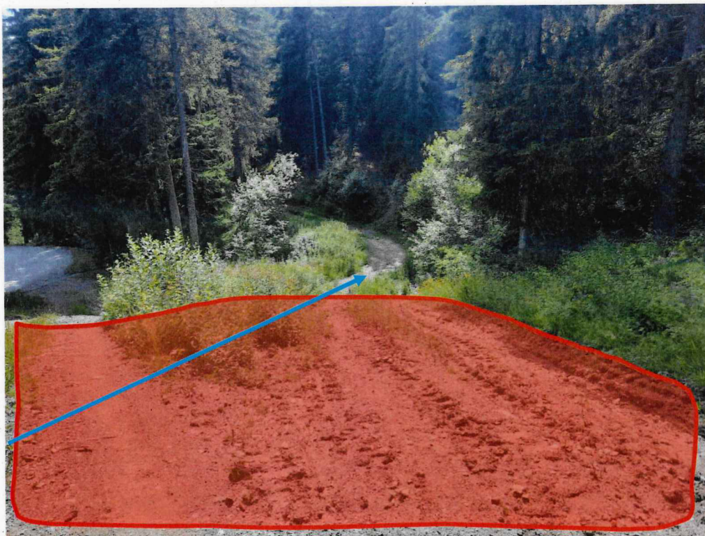
Photo 1: Butte à araser (en rouge) pour permettre le basculement (en bleu) sur l'arrivée de la Nationale.
